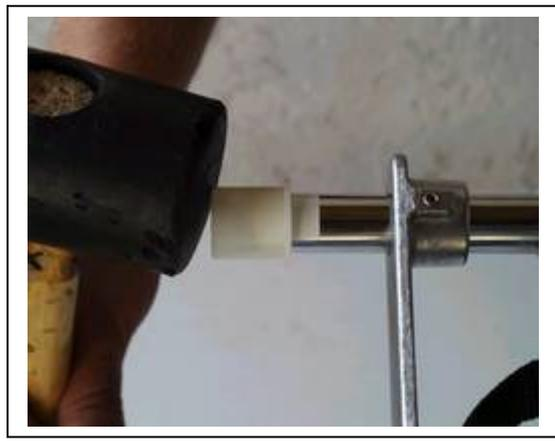
Abb. 13 Aufschlagen der Kunststoffführung
